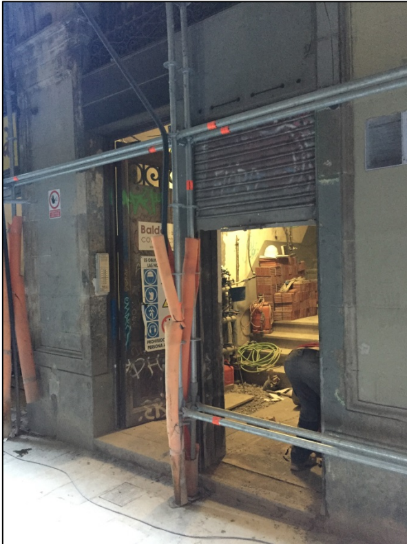
FOTO 05. Entrada a l'immoble pel carrer Gignàs
