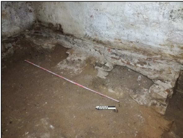
FOTO 28. Soterrani 1. Àmbit 2. Restes contemporànies
