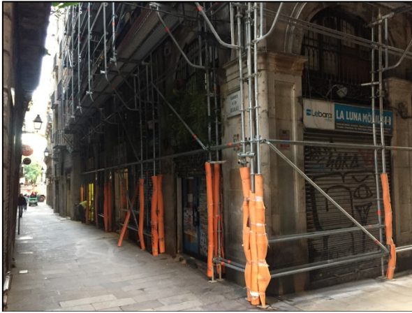
FOTO 01. Façana del edifici (cantonada carrer de Regomir)
