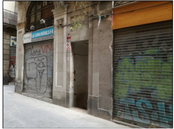
FOTO02. Façana de l'edifici al carrer Regomir
