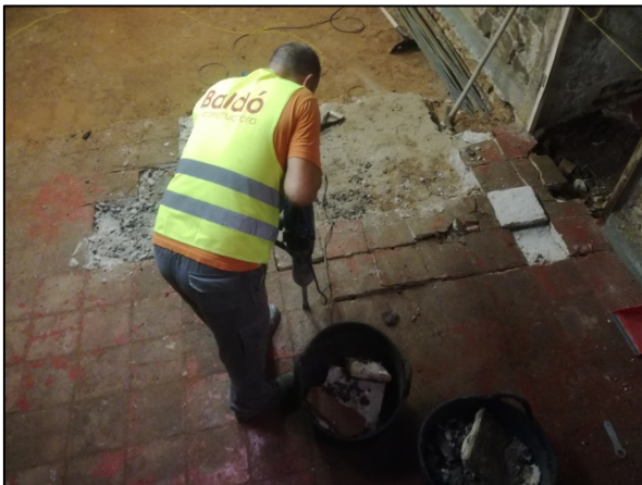
FOTO 11. Desmuntatge paviment soterrani 1
