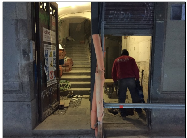
FOTO 51. Inici excavació rasa serveis
