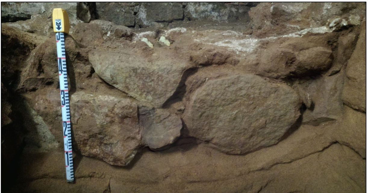
FOTO 35. Soterrani 1. Àmbit 2. Sondeig. Fonamentació UE 2007
