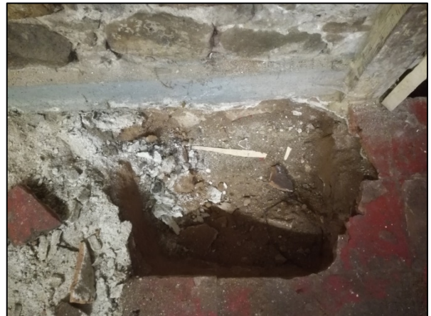
FOTO 08. Cales de comprovació de la fonamentació
