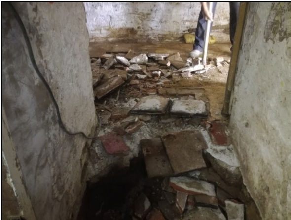
FOTO 21. Soterrani 1. Àmbit 2. Desmuntatge paviments
