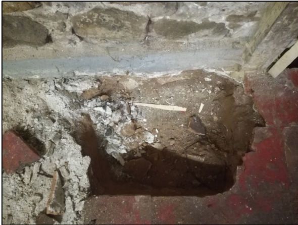
FOTO 09. Cales de comprovació de la fonamentació
