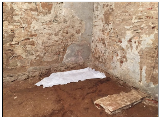
FOTO 47. Soterrani 2. Cobriment mur UE 3010
