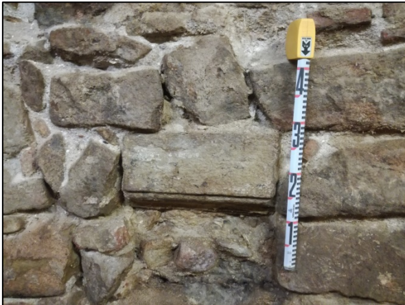
FOTO 42. Soterrani 1. Detall de carreu reaprofitat
