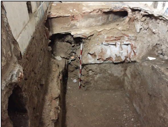
FOTO 54. Fossat ascensor. Detall galeria enrunada i riostra del pati de llums
