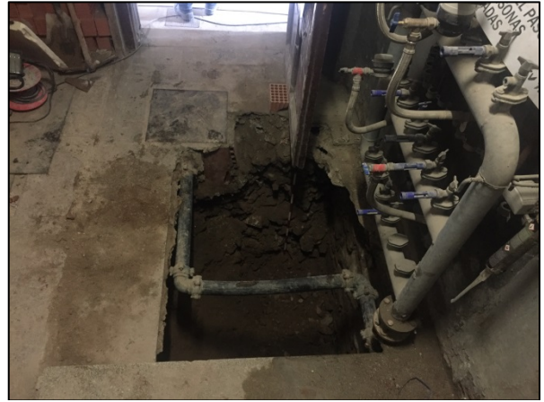
FOTO 49. Registre de clavegueram. entrada a l'immoble
