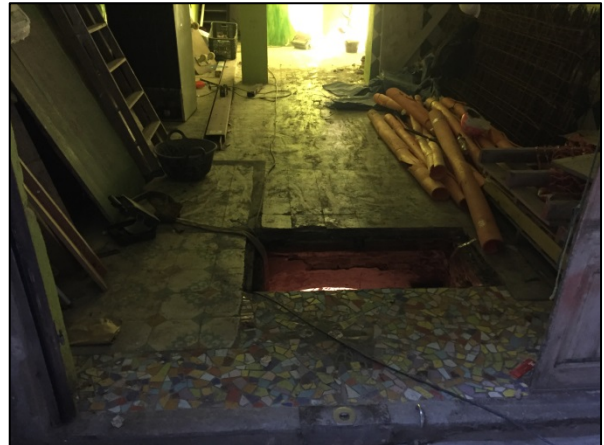
FOTO 43. Entrada al soterrani 2 des de local 4
