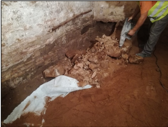
FOTO 38. Soterrani 1. Àmbit 2. Desmuntatge UE 2007
