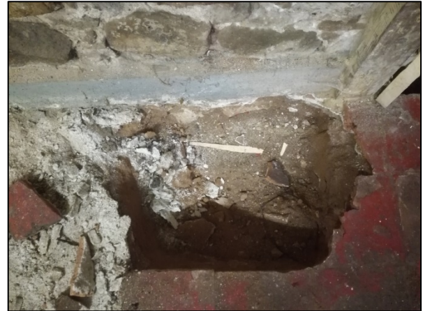
FOTO 10. Cales de comprovació de la fonamentació
