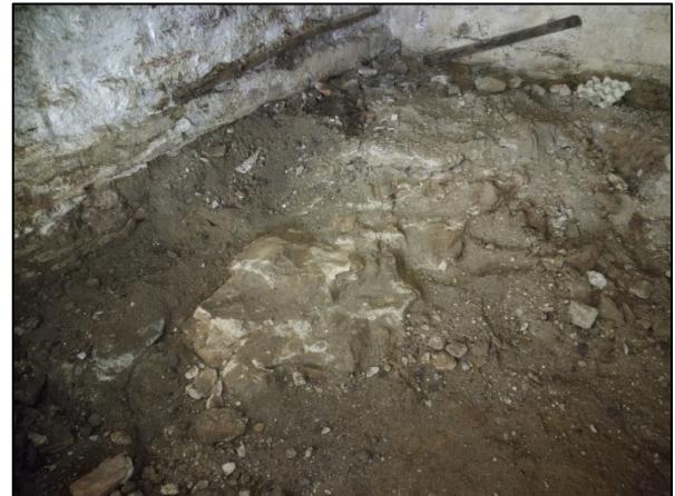
FOTO 22. Soterrani 1. Àmbit 2. Aflorament del mur UE 2007
